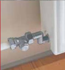
Der Kermi Adapter-KD für Kompaktheizkörper sorgt ebenfalls für eine problemlose Anpassung an das vorhandene Rohrnetz durch den Ausgleich von Nabenabstandsdifferenzen.
